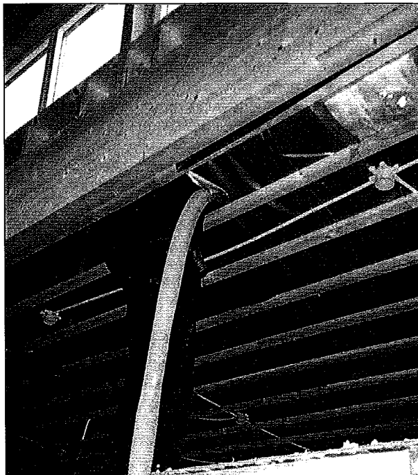
Vid installation av lösullsisolering i parallelltaket på bilden skars tätskiktet upp. Genom hålet sprutades därefter isoleringen in. Lagningen av hålet utfördes med en fiberduk som häftades till den intilliggande glespanelen. Lufttäteten bedöms vara dålig i detta skikt. Hus 5.
